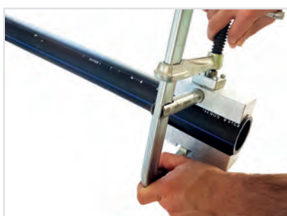
2 Désovaliser le tube si nécessaire
