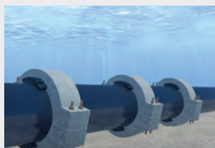
Buter les éléments de lestage d'un tube
