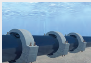
Buter les éléments de lestage d'un tube
