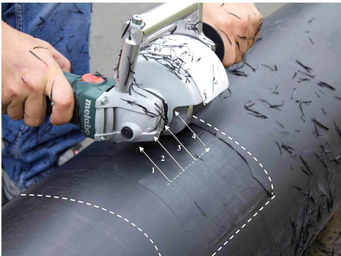
5. Répétez les étapes précédentes jusqu'à ce que toute la zone marquée soit grattée. Les deux roues de guidage sont conçues et calibrées de manière à travailler de la façon décrite. La profondeur de raclage spécifiés dépend du respect des consignes d'utilisation.
