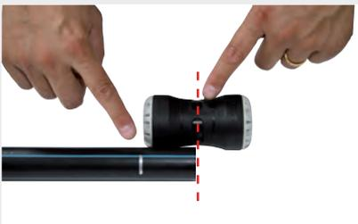
Le tube doit être emboîté jusqu'au milieu du raccord. Marquer la profondeur d'emboîtement sur le tube.
