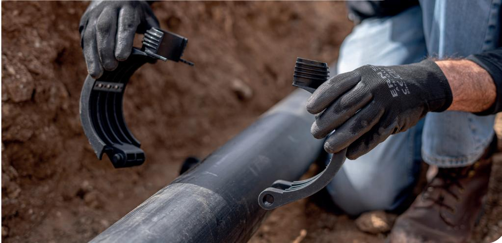
Collier de prise pour tubes PE et PVC **SANS boulonnerie**
