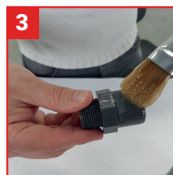
3 Appliquer la colle spécial PVC sur les emboîtures.
