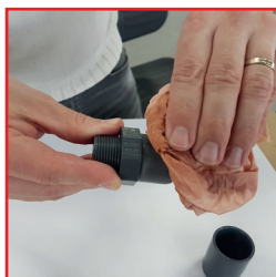
2 Nettoyer les emboîtures à l'aide de décapant spécial PVC.
