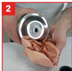
2 Nettoyer les emboîtures à l'aide de décapant spécial PVC.
