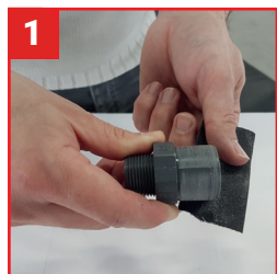
1 Poncer l'emboîture mâle et femelle des raccords.
