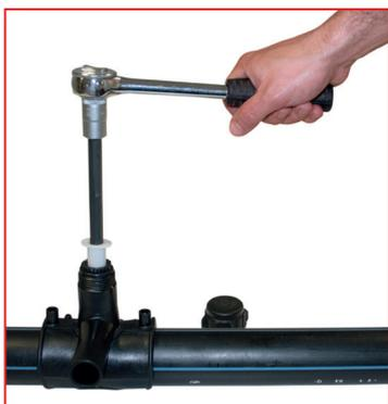
**5 Mettre en place** la prise de branchement, serrer les boulons pour positionner la prise. Pour les prises FASTCLAMP, le bon positionnement est atteint lorsque les cylindres sont en contact ferme par serrage de la poignée à la main.
